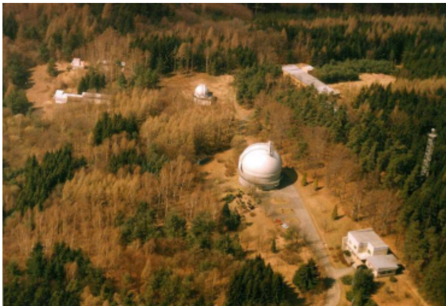
Kopule dvoumetrového dalekohledu Astronomického ústavu AV ČR, v.v.i., v Ondřejově.
